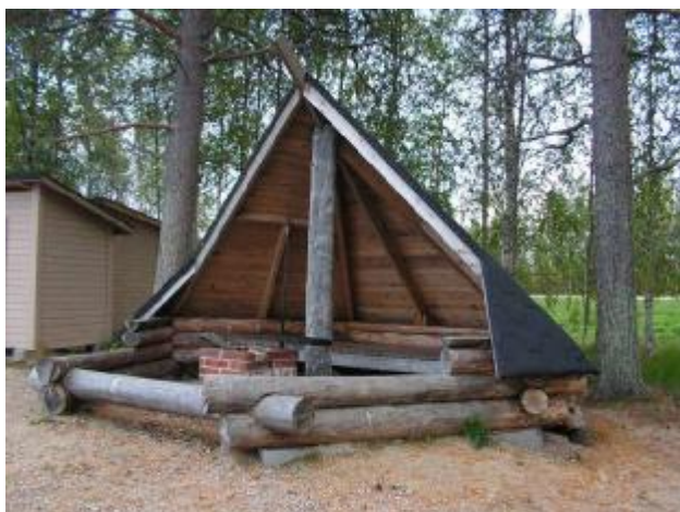
Фото 4.3.7. Пример конструкции места для костра (костровища) и скамей с навесом
