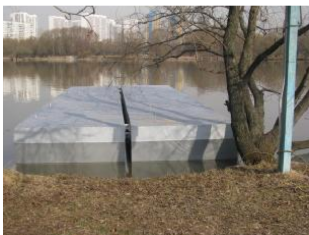
Фото 4.3.11. Пример конструкции причала для маломерных судов: понтон, 12 м (источник: http://skeverest.com/pontony_i_pontonnye_osnovaniya )
