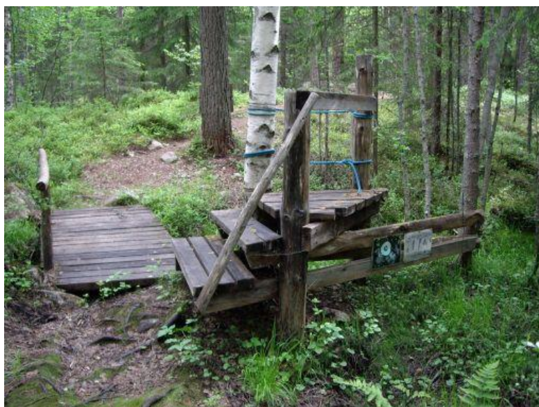
Фото 4.3.2. Пример конструкции смотровой площадки и пешеходного мостика
