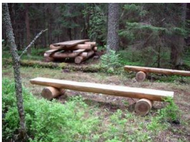
Фото 4.3.5. Пример конструкции деревянных скамей и стола
