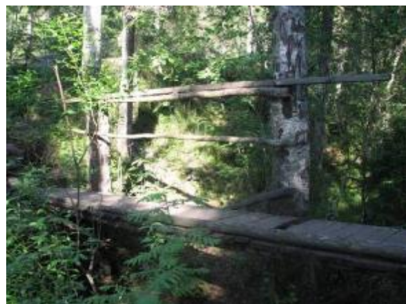
Фото 4.3.3. Пример конструкции пешеходного мостика
