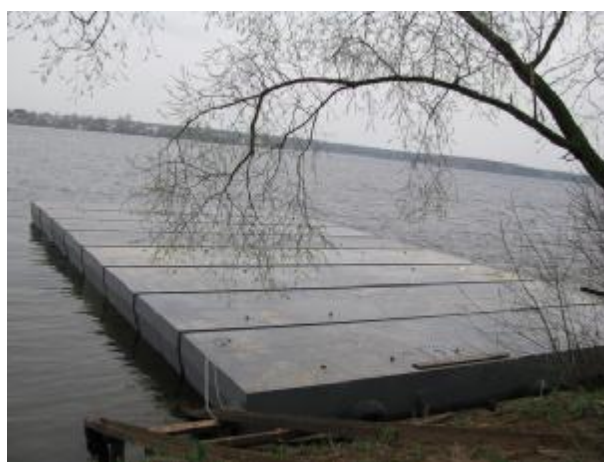
Фото 4.3.11. Пример конструкции причала для маломерных судов: понтон, 12 м (источник: http://skeverest.com/pontony_i_pontonnye_osnovaniya )
