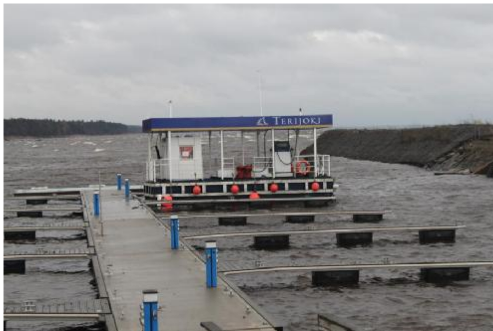
Рисунок П13.2 – Пример плавучей заправочной станции (фотография из http://www.fse-spb.ru/objects_p_4.html )
